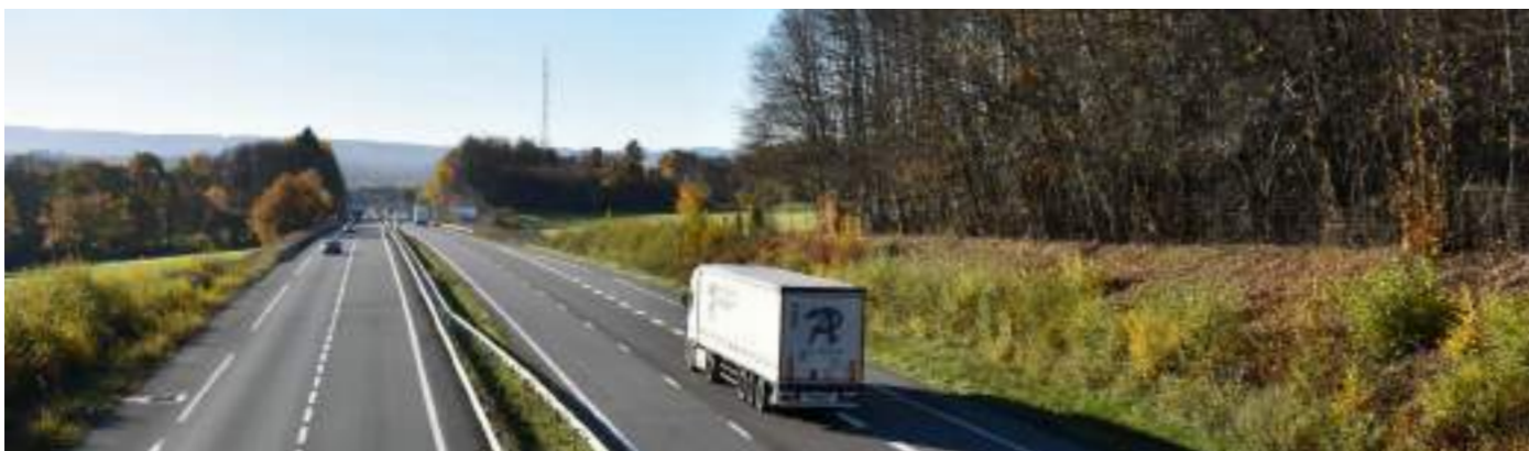
Photographie 2 : Autoroute A20 depuis le pont de la D93.
